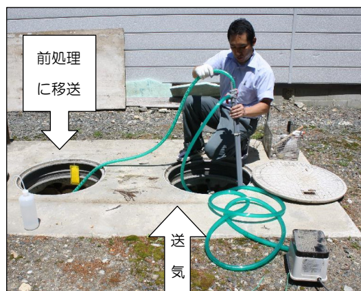
図-11 実際の汚泥移送作業
