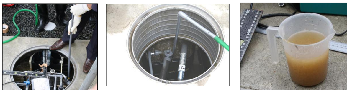
生物ろ過槽へ逆洗
